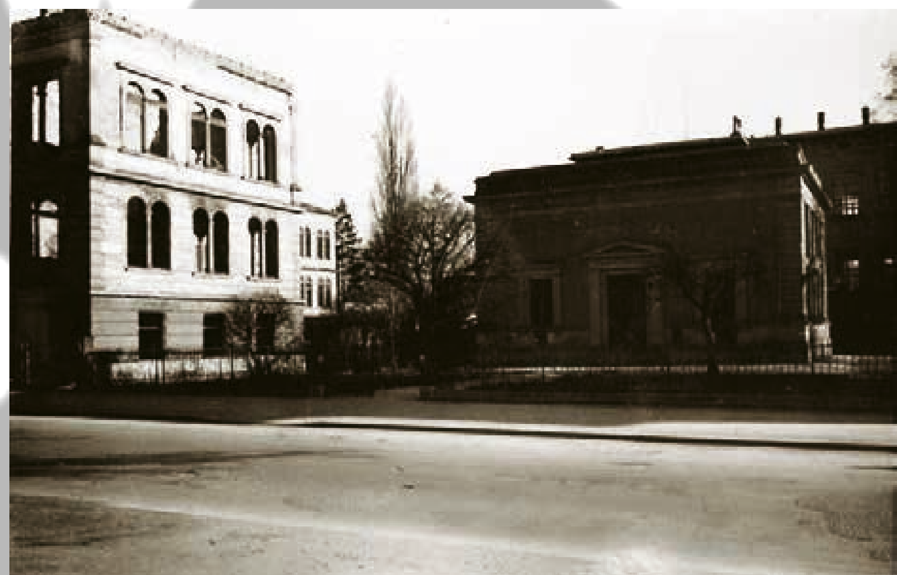
ZOOLOGISCHES INSTITUT NACH DEN AUFRÄUMARBEITEN (1947).
