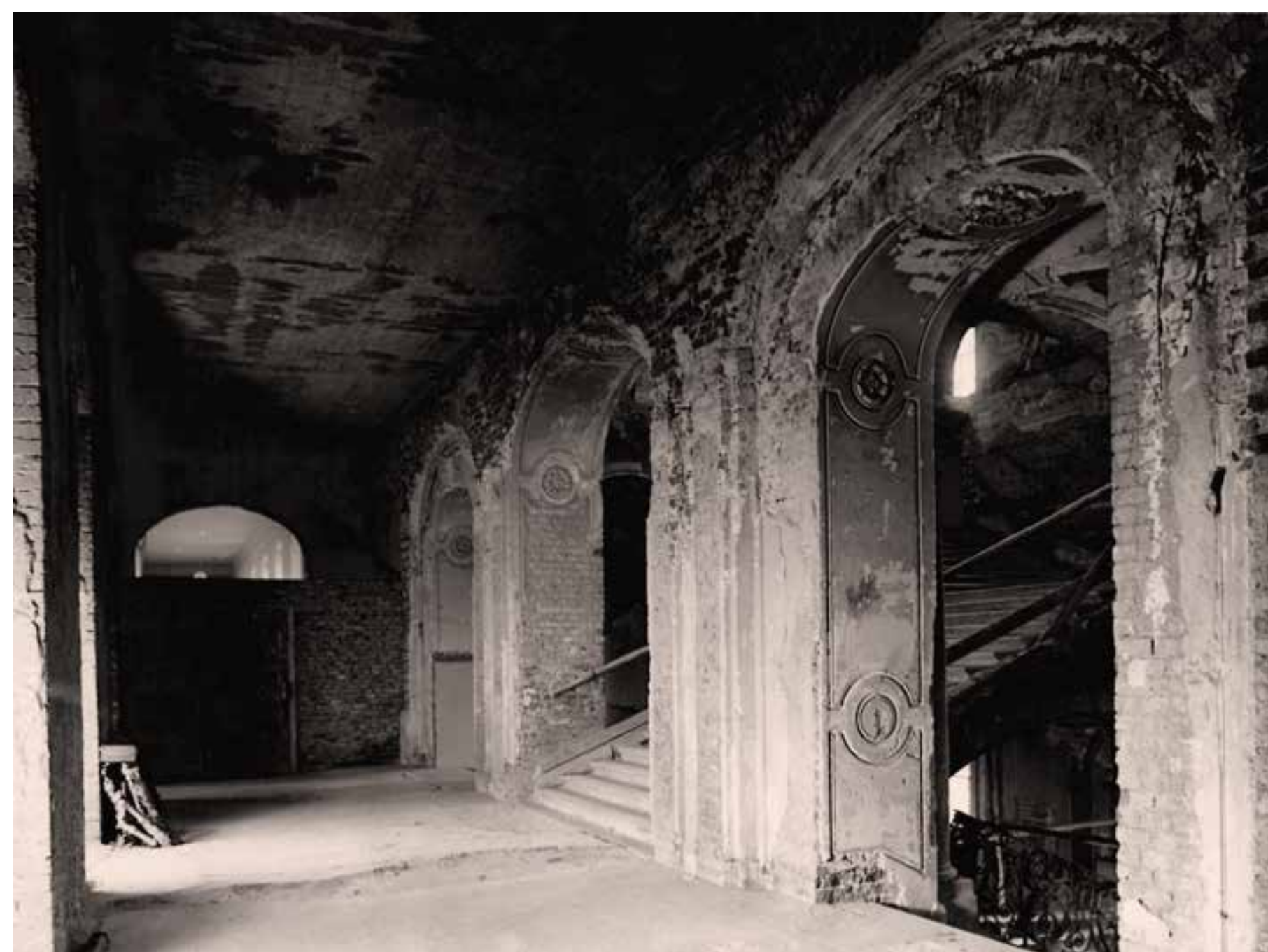
DAS TREPPENHAUS DER NEUEN UNIVERSITÄT NACH DER SCHUTTRÄUMUNG.
