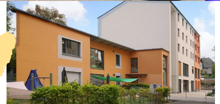
Im Vordergrund das Bestandsgebäude der Kinderkrippe. Im Hintergrund der Neubau mit Wohngruppe und Kindergarten.
