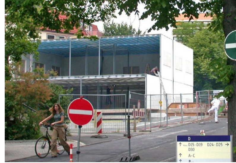
Bauphase: Im Mai 2004 war die Kubatur des Gebäudes D30 bereits zu erkennen.
