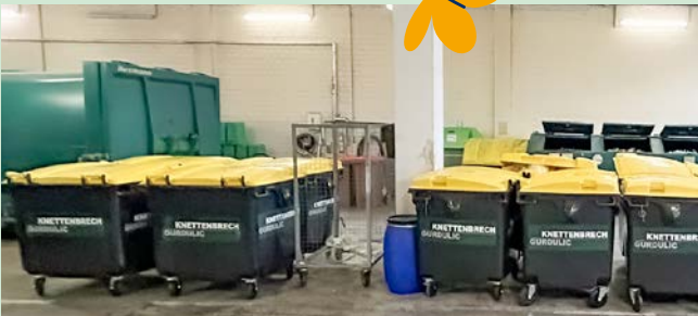
Mehr Raum für Wertstoffe: In den Zentren für Operative und Innere Medizin wurde die Sammelkapazität um 12,5 m³ erweitert. Insgesamt stehen dort nun 18 Container zur Verfügung.
